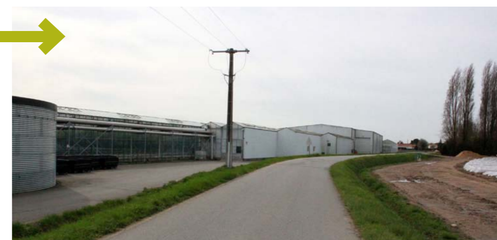
• Le Bout des Ponts/Les Carroueils : après arrachage de haie
