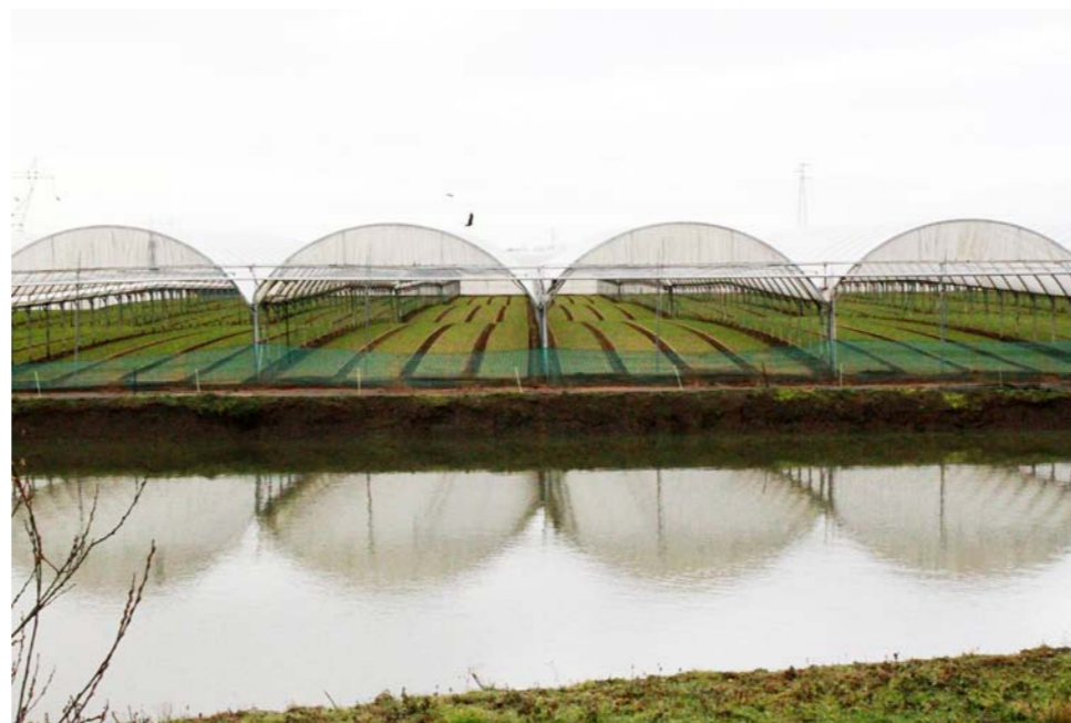
1 Bassin de rétention en avant plan des GAP
