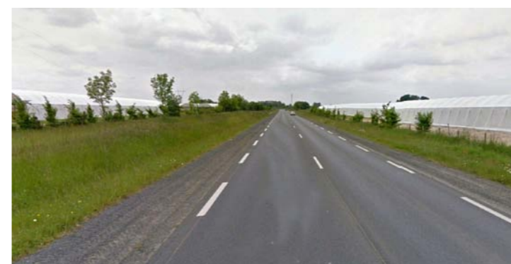
4 La voie « nouvelle » autour de laquelle le paysage se referme. Les abords sont souvent plantés, mais d'autres dispositifs pourraient mieux les accompagner (travail sur l'eau, orientation et implantation des GAP, palette végétale...)
