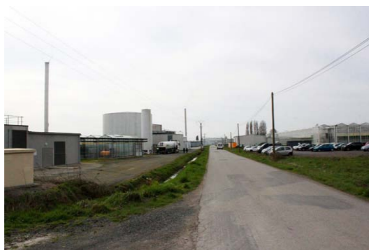
2 Traversée d'exploitation (depuis route publique) avec majoritairement perception des parties techniques. Les serres sont relativement masquées, relayées à l'arrière (en coulisses), alors que ce sont elles qui peuvent faire office de vitrine de l'activité
