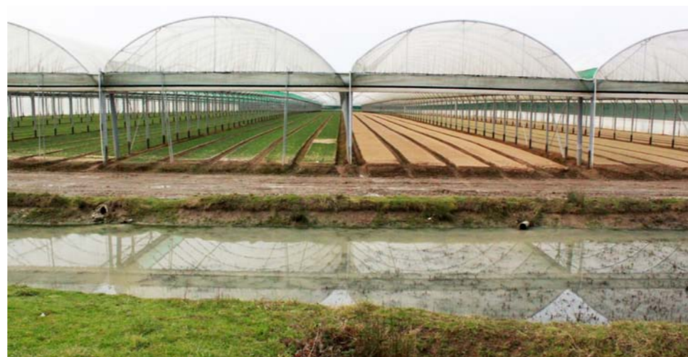
1 Bassin de rétention en avant plan des GAP
