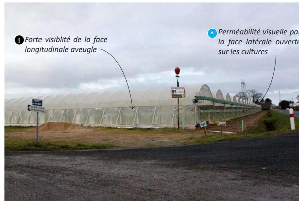
• Absence de haie autour d'un GAP
