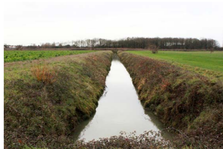
• Fossé/canal de drainage
