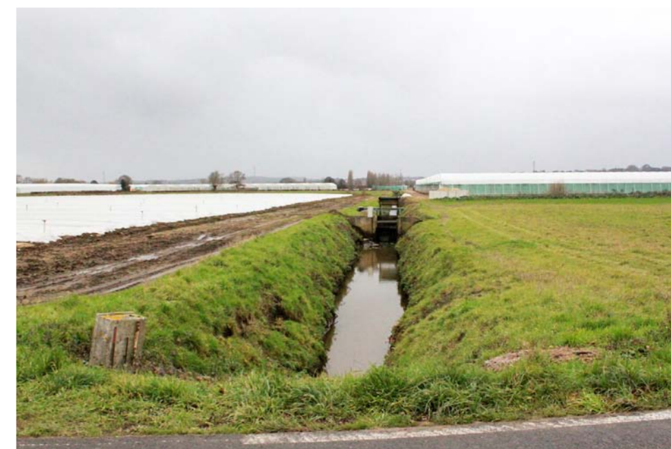
2 Présence lisible des ouvrages de régulation des eaux de drainage
