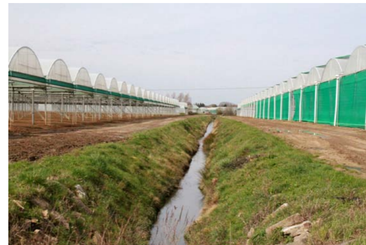
• Fossé de drainage
