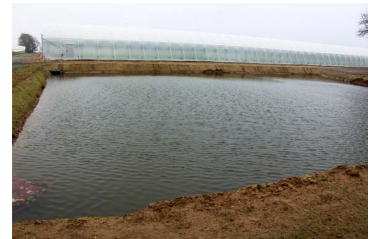
• Bassin de rétention
