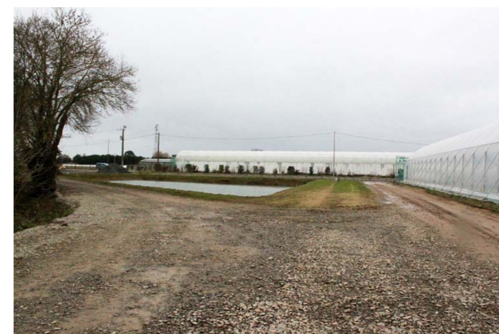
• Bassin de récupération des eaux pluviales des GAP
